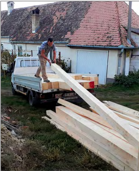
Lieferung der Dachbalken Foto: Horst Kloos
